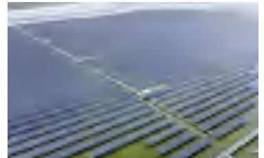
全球单体容量最大的盐光互补项目-天津海晶100万千瓦盐光互补光伏电站
